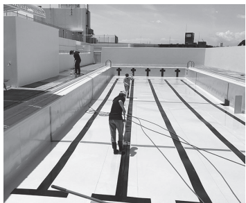
きれいになったプール
