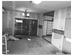
改修工事中のリビング
