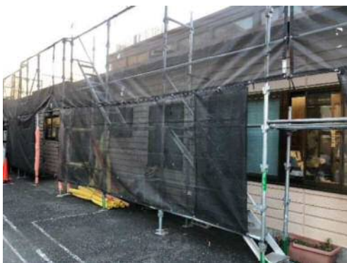
みどり福祉ホーム大規模改修足場の様子
