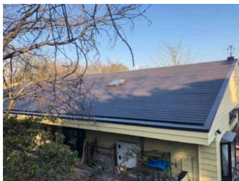
活動ホームあさひ大規模改修屋根吹替後の様子
