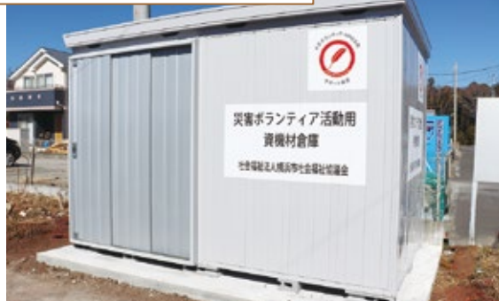
泉区に設置された資機材倉庫
