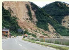
▲土砂崩れの様子
